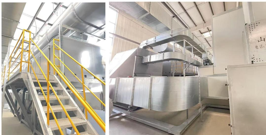
图 3-2 “干式过滤+活性炭吸附脱附催化燃烧”废气治理设施
