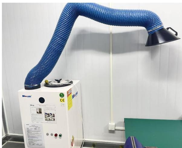
图 3-4 “移动式滤筒除尘器” 废气治理设施
