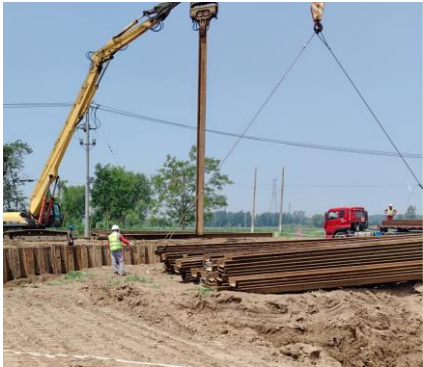
风电机组机位板桩施工
