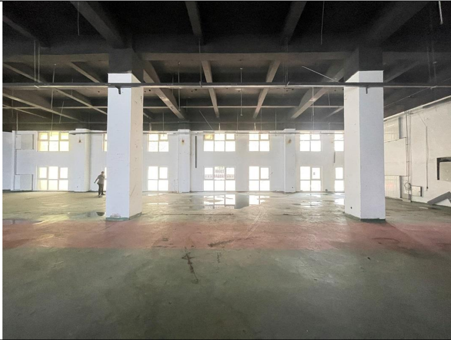
厂房内部现状情况
