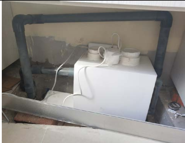
污水处理设施
