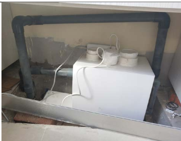
图 3-1 污水处理设施
