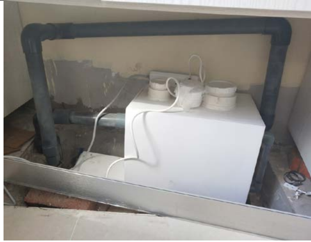
图 3-5 污水处理设施
