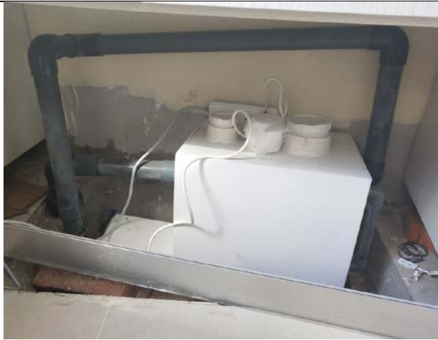
图 3-6 污水处理设备
