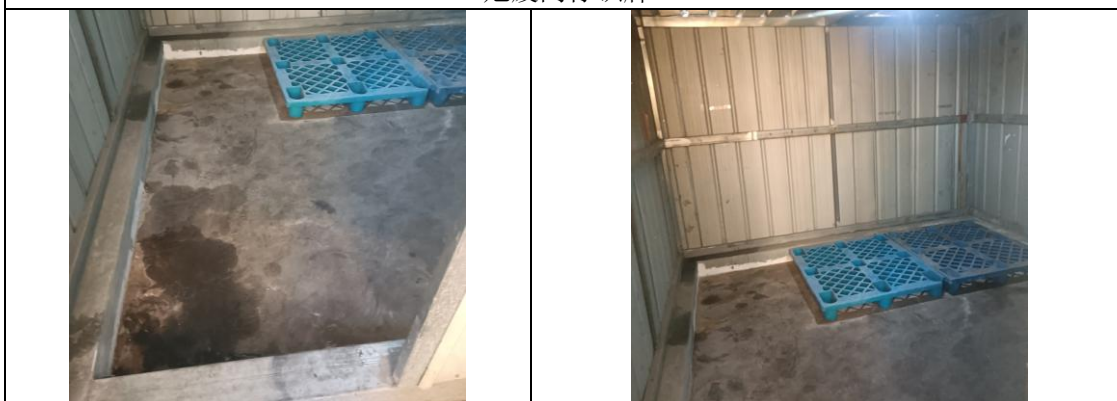
危废间内部现状
