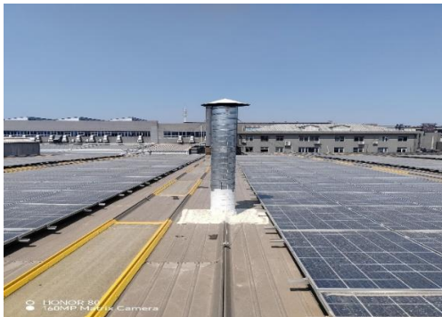
DA031 排气筒（本次扩建保留）
