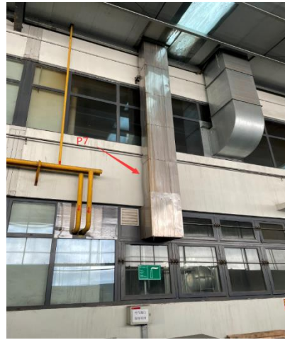
图 11 排气筒 P5 (壁挂炉)
