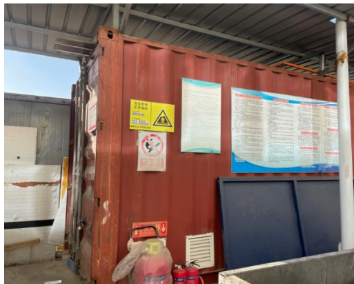
图 12 危废暂存间外部
