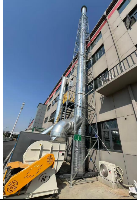
DA005 排气筒规范化标识牌
