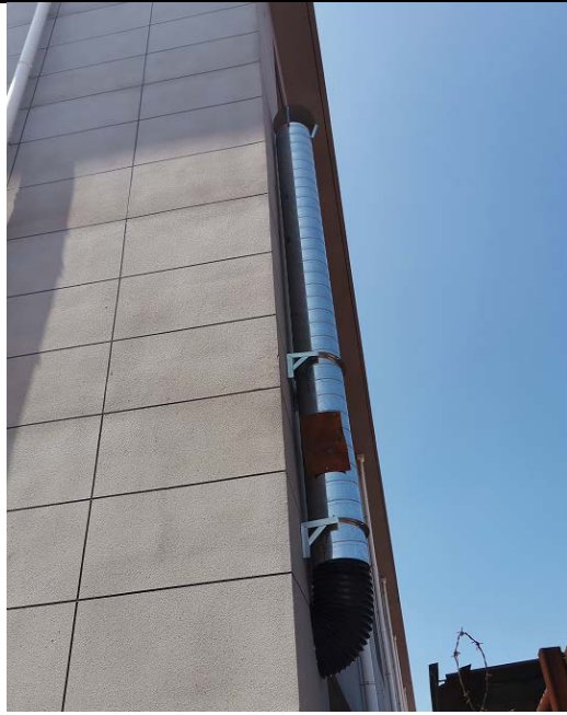
油烟净化器排气筒
