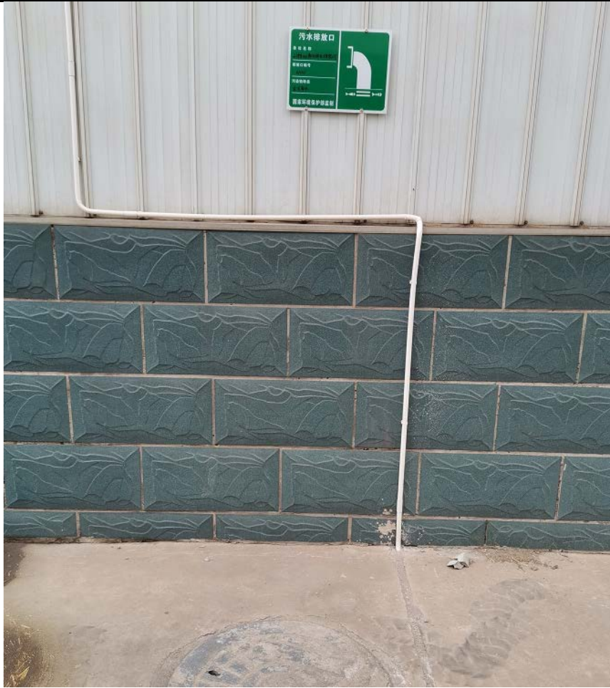
污水总排口标识牌
