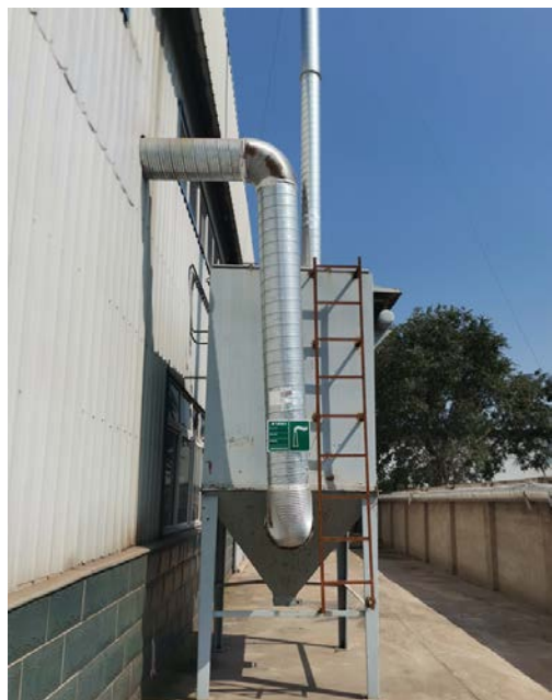
布袋除尘器和排气筒 P1
