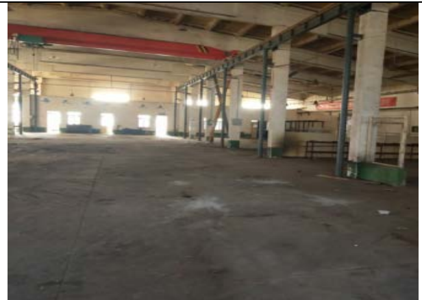
图9 本项目厂房内部
