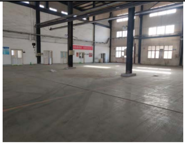
图7 本项目厂房内部
