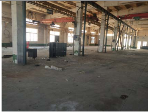
图8 本项目厂房内部
