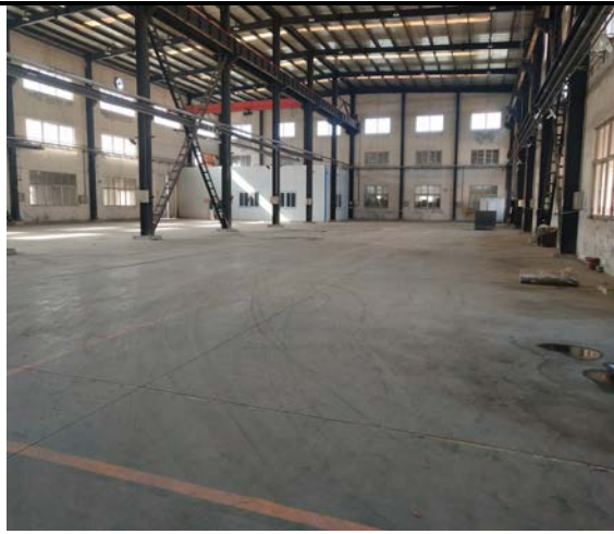
图6 本项目厂房内部
