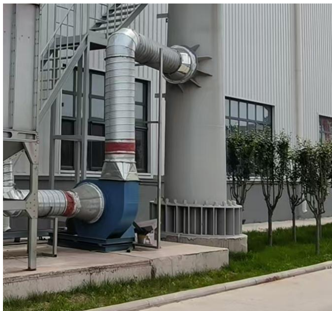
风机基础减振
