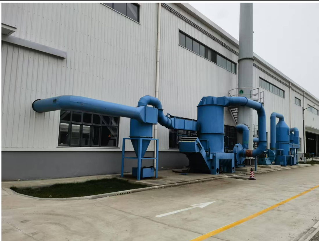
旋风除尘器+湿法除尘器+板式过滤器
